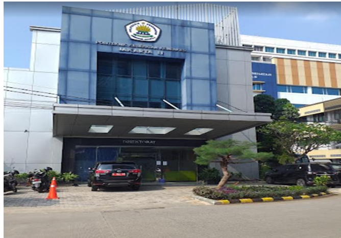
Gambar 4.1. Lokasi Program Studi Sanitasi Poltekkes Jakarta II
